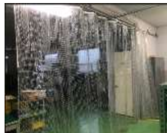
省エネ間仕切り
