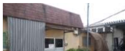
第三工場シャッターへ遮光シート(一基追加)設置 (CO2、電力量削減)
