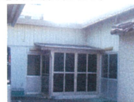
第三工場コンプレッサ室遮光シート設置 (CO2、電力量削減)
