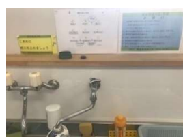
節水の推進(蛇口をレバー式に変更)
