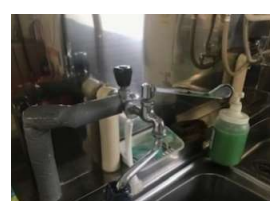
節水の推進(蛇口をレバー式に変更)
