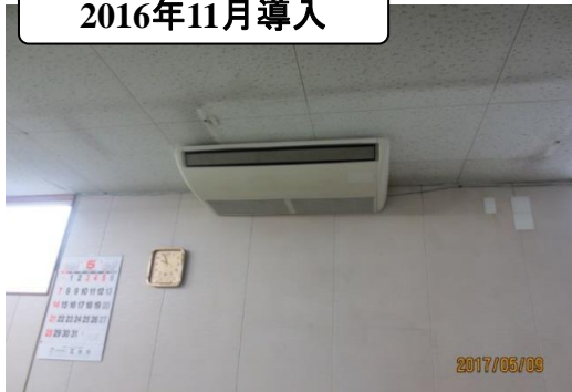
第三工場、空調機器入替により、 効率化 (CO2、電力削減) 7.5kw→3kw、R22→R401a
