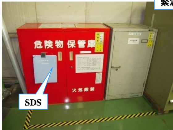
危険物保管庫による薬品管理
