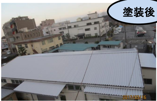
第二工場の屋根断熱塗装による節電 (CO2、電力量削減)
