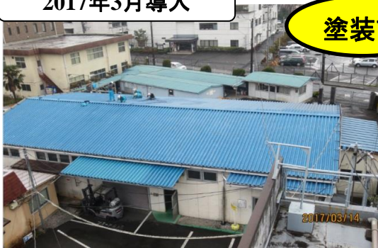
第二工場の屋根断熱塗装による節電 (CO2、電力量削減)
