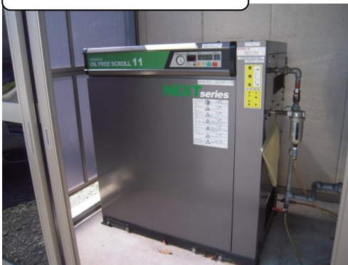
省エネ オイルフリーコンプレッサー タイプの運転
