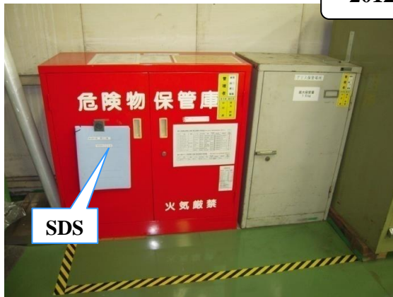
危険物保管庫による薬品管理
